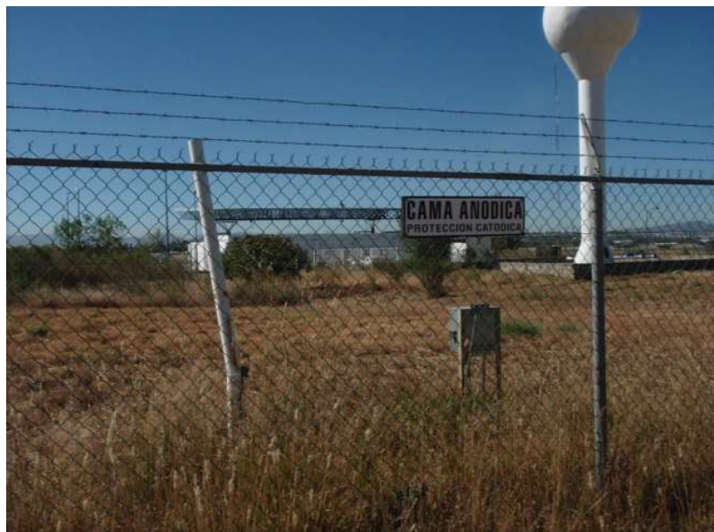
Foto 6. Área donde se ubica la cama anódica del sistema de protección catódica
