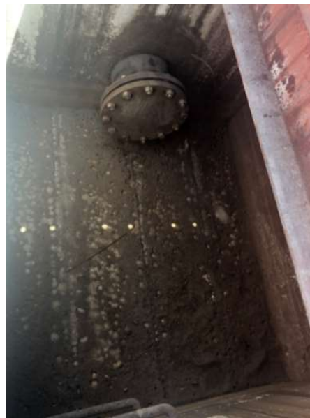
Foto 3. Registro al final del cabezal (RT-14)
