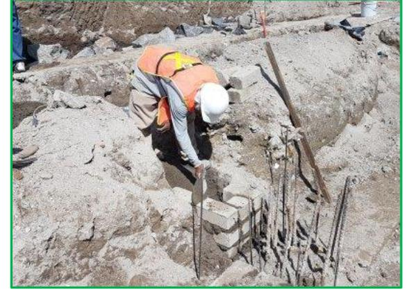
Plantilla de concreto y base para plantilla forjada con block hueco.
