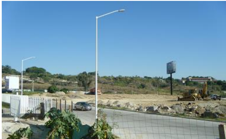
Foto 15. Trabajos de urbanización del predio del municipio enfrente del de proyecto.
