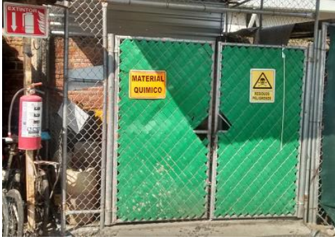
Foto 13. Señalización y extintor con que debe contar el almacén de sustancias y residuos peligrosos.
