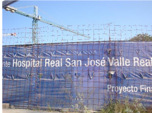
Foto 24. Hospital Real san José Valle Real en construcción.
