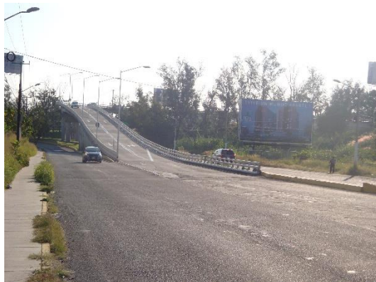
Foto 48. Luminarias en la Av. Central.
