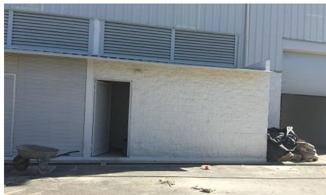
Foto 12. Almacén terminado a usar como de Residuos Peligrosos.
