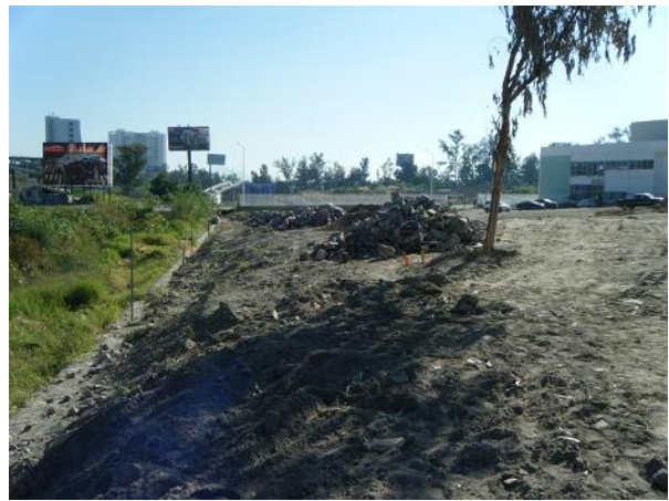
Foto 51. Imagen del predio de proyecto, a la derecha el edificio de la primera etapa, y a la izquierda el arroyo La Campana, que será delimitado con barda perimetral del complejo del CIATEJ, como la del frente, respetando su delimitación federal.
