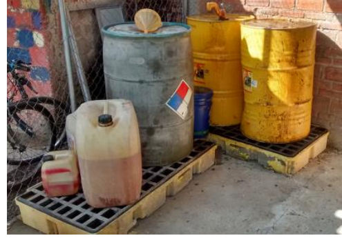
Foto 14. Ejemplificación de sistema de contención de derrames a través de Charolas para este tipo de almacén temporal.
