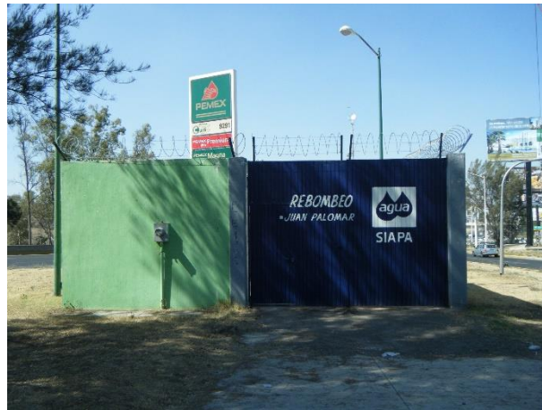
Foto 47. Imagen de la Estación de bombeo perteneciente al SIAPA, en la Avenida Juan Palomar y Arias en su entronque con el Anillo Periférico Manuel Gómez Morín.
